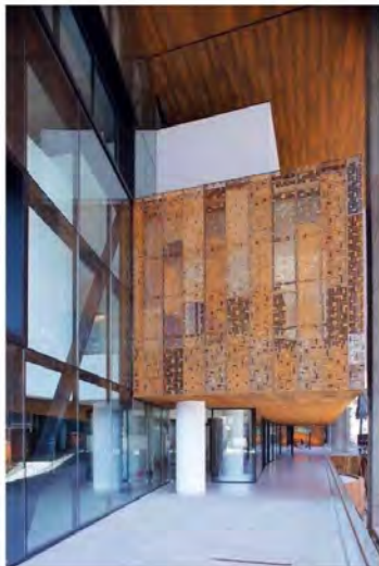
El acero corten contiene cobre, cromo y níquel que le dan el color rojizo característico.
