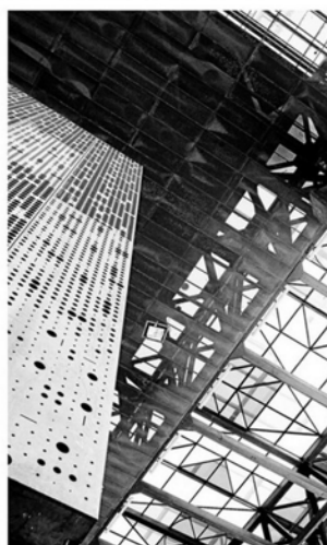
► Planchas de hierro y cobre perforadas que generan una oxidación estable y un aislamiento térmico. FOTO GAM
